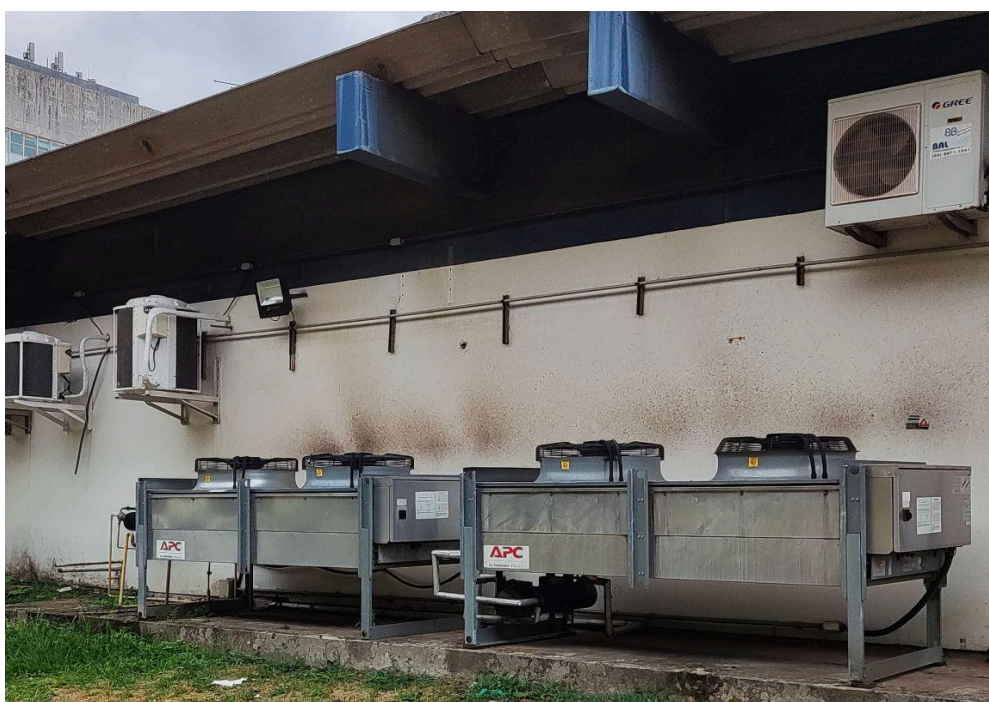
Foto 3: Local externo para instalação das condensadoras.
